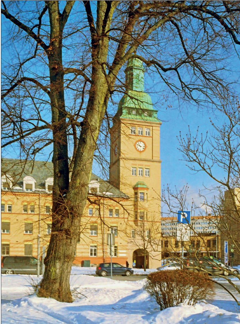
Figur 2: For tiden (2018) er Ullevål universitetssykehus i Oslo truet av nedleggelse (9). Administrasjonsbygget med klokketårnet fra 1924 er det som i vår tid ville bli kalt et «signalbygg» som gir anlegget identitet. Likevel er identiteten ikke statisk. Som vist av blant andre Kåresen (9), har en del av identiteten til sykehusanlegget siden åpningen i 1887 vært nettopp den stadige byggevirksomheten og den kontinuerlige tilpasningen til funksjonene. Det kan være et av argumentene for å fortsette i samme spor. (Foto: Øivind Larsen 2018)
